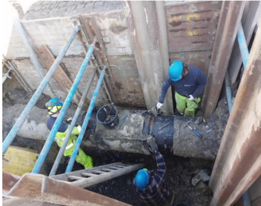
Fertig umhülltes U-Stück nach Abdichtarbeiten und Spannungsdurchschlagtest
