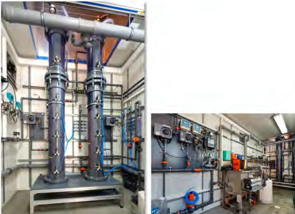
Abbildung 5: Innere des IWW-Versuchscontainers mit Filtersäulen, Flachbelüfter und Messgeräten
