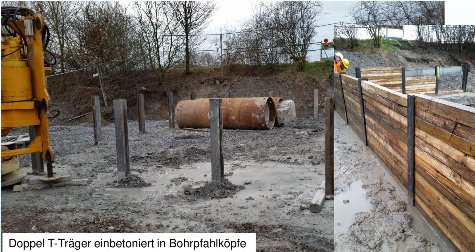
Doppel T-Träger einbetoniert in Bohrpfahlköpfe
